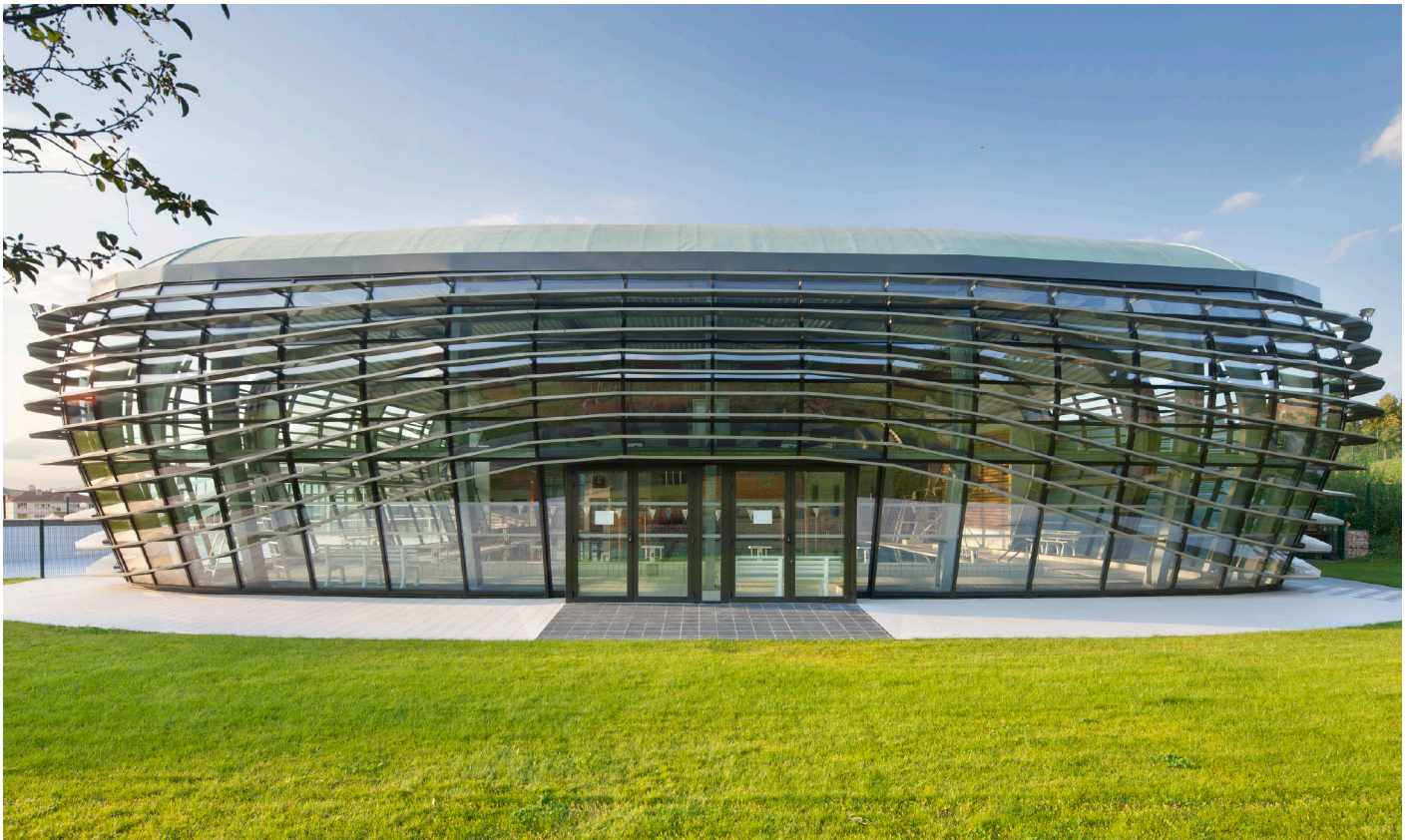
Piscine de Billom (63) - Architecte : MBA Architectes - Ch. Blanchet - Façade Kadrille AA100®
