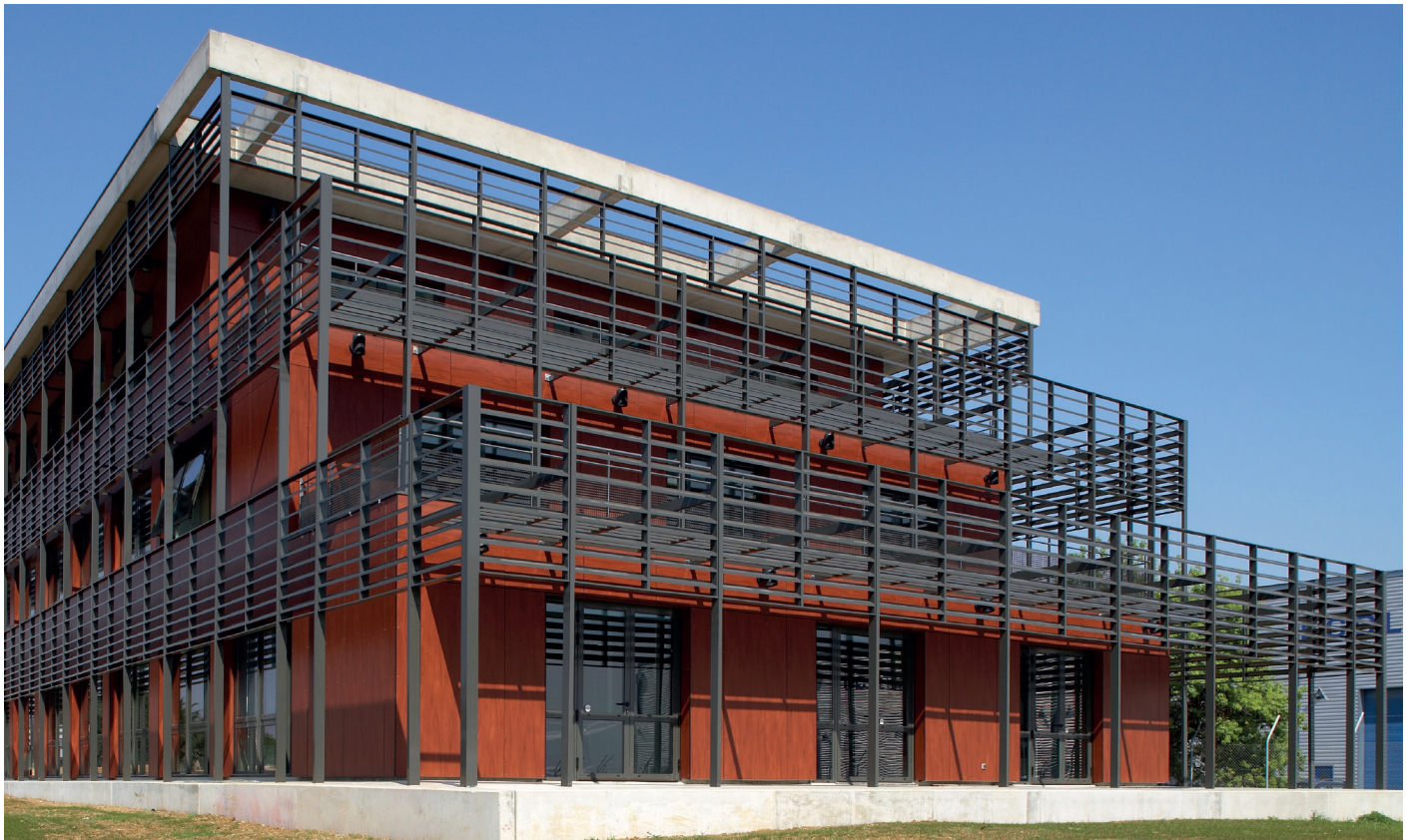
Brise-Soleil Kalumen® - Bureaux Icare Lounge - Architecte : Blue Tango Architecture - Philippe Capelier
