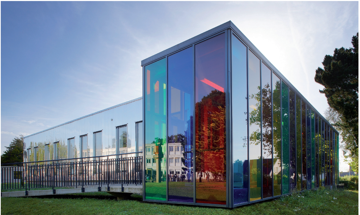
Collège Le Hérault de Saint-Herblain - Architecte : BCL Architecte - Façade Kadrille 1202®
