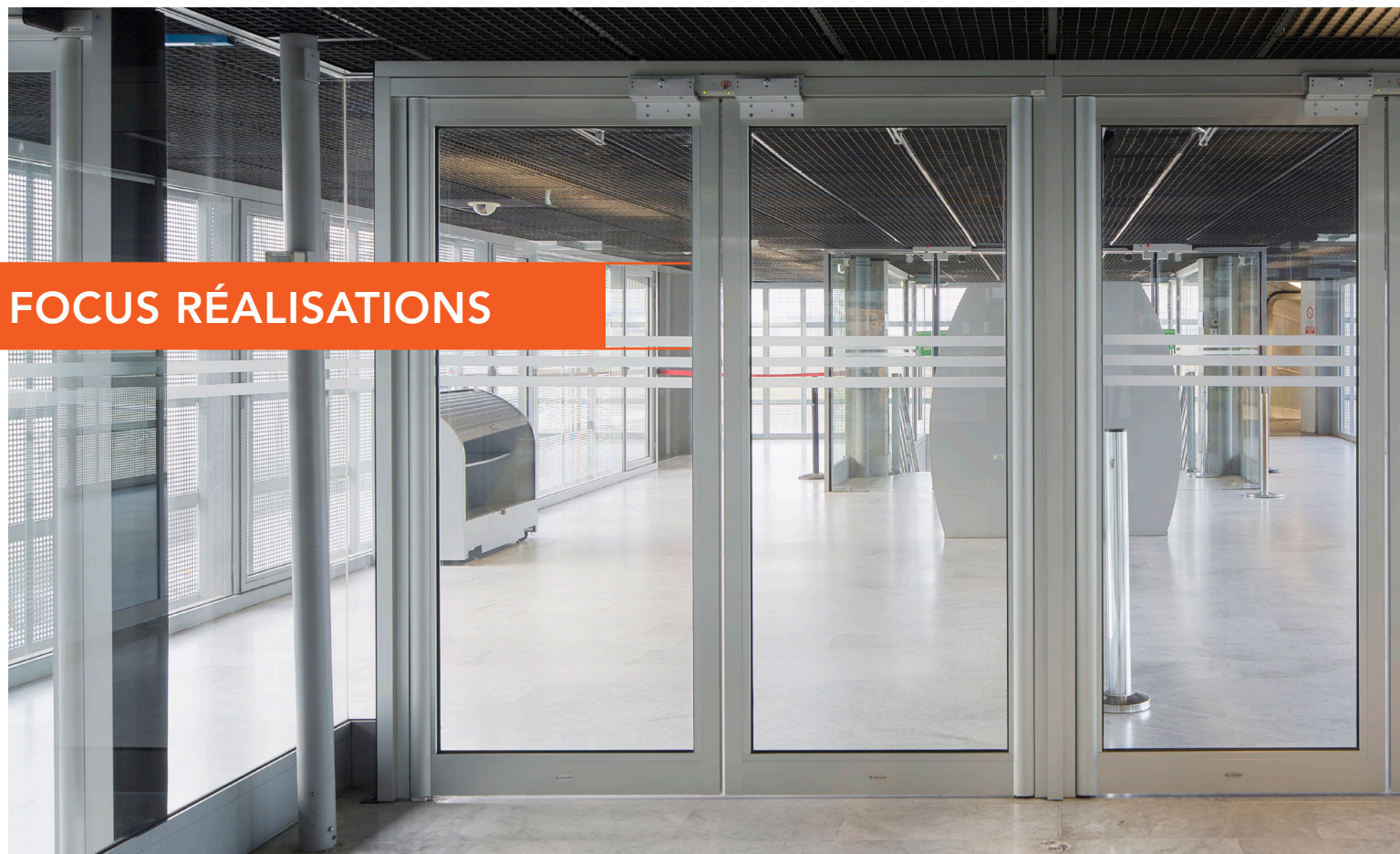
Aéroport Toulouse Blagnac - Portes K190 RPT® 2 vantaux avec ouverture automatique et système anti pince-doigts
