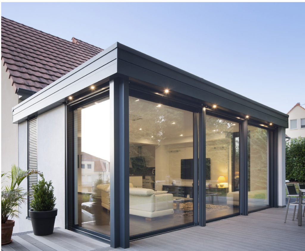
Véranda à toiture plate
